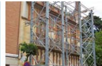
Estabilización de Muros y Fachadas
